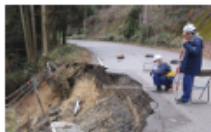
危険箇所での被災状況調査
